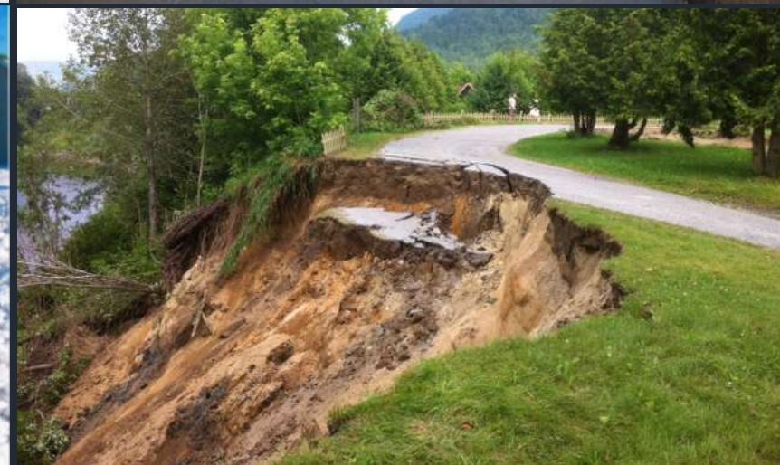
Photo 1: Côté amont du pont le 15 janvier 2004
